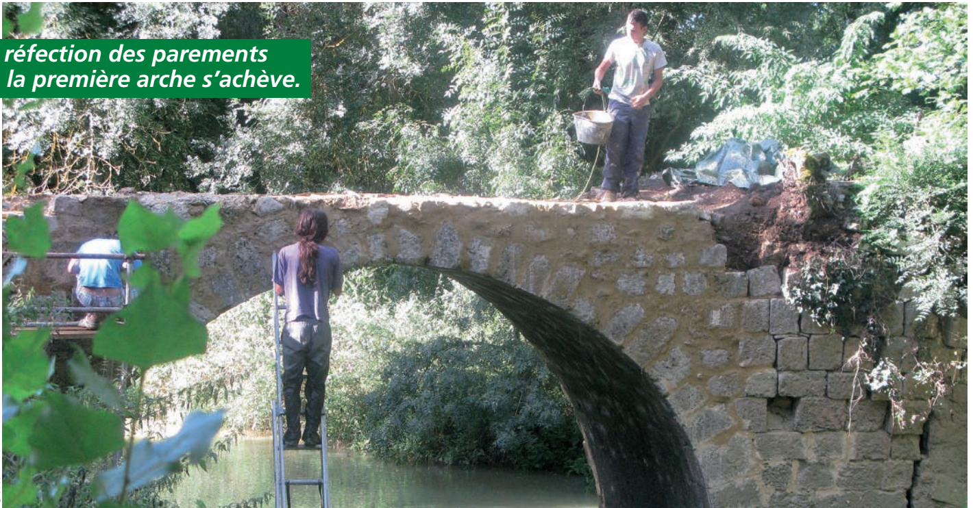
Le calage des maçonneries.
